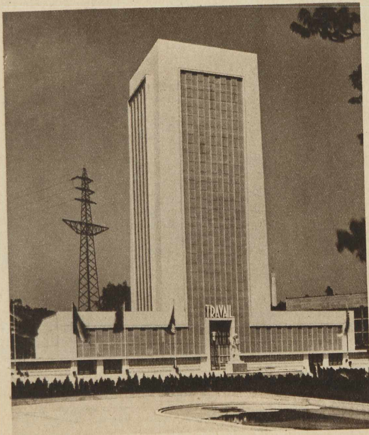
Le Palais du Travail. Arch. Plumier. (Photo G. Jacoby, Liège.) Revêtements extérieurs exécutés au moyen de plaques ondulées Johns Manville et Arconite. Hauteur de la Tour : 50 m.
