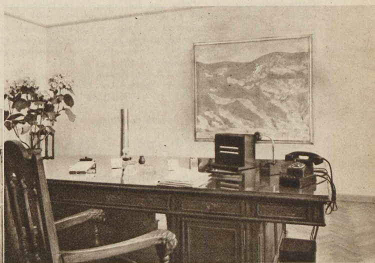
Poste téléphonique du bureau du Directeur général, contenant lampes de contrôle, dispositif de conférence et amplificateur de conversations téléphoniques type « Radio-Dialogue ».
